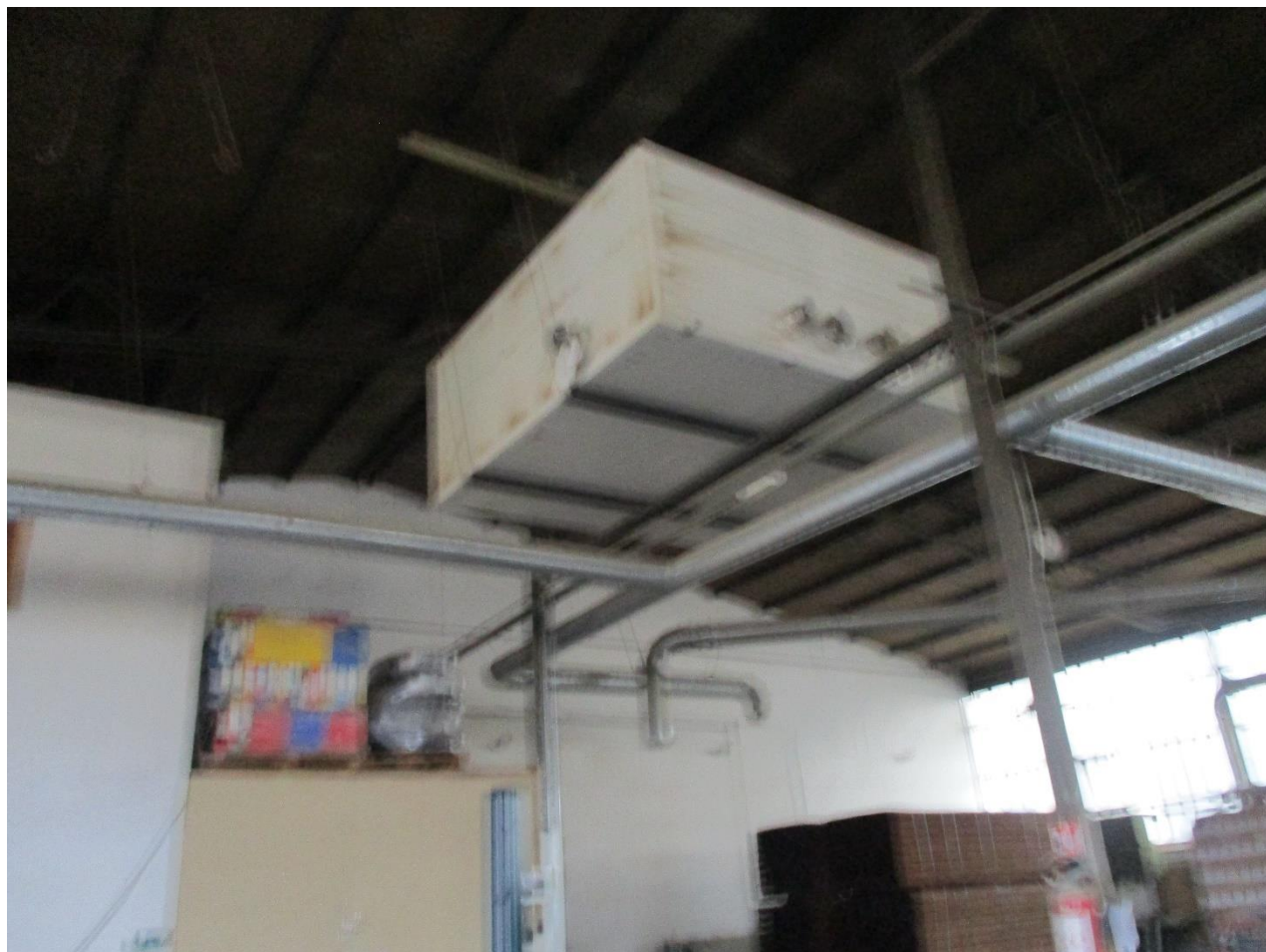
Slika 2. Sustav za distribuciju toploga zraka
